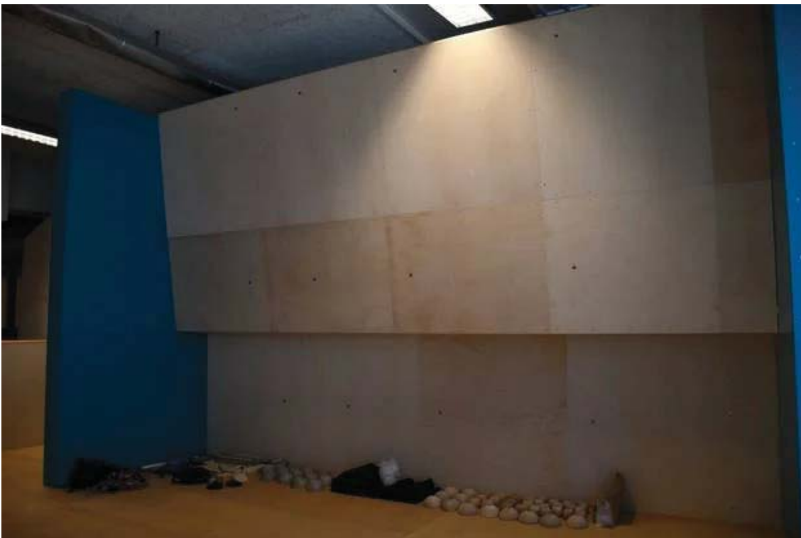
Hier entsteht eine Trainingswand für die Fingerkraft.© Janine Müller
